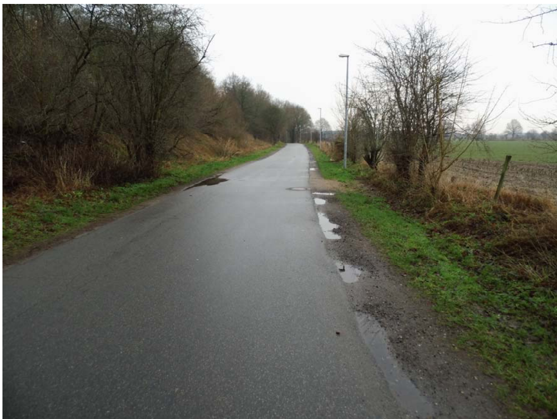
Bild 2: Aspelweg, Abstand Fahrbahnkante zur Lampe ca. 1,80 m
