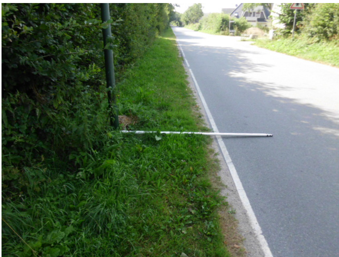
Bild 1: Alter Aspel, Abstand Fahrbahnkante zur Lampe ca. 1,20 m
