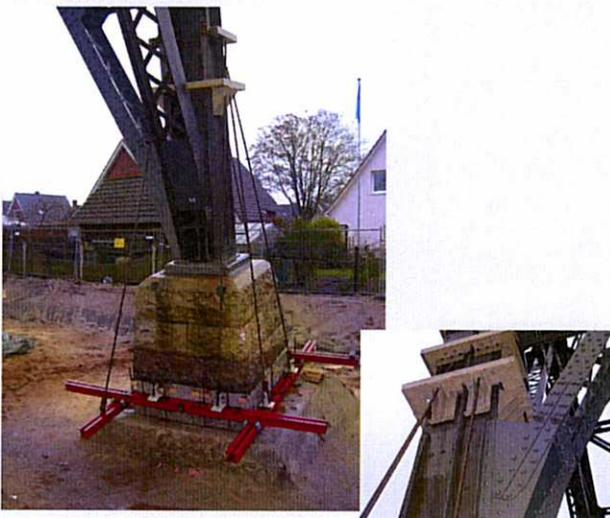
Die Bauehilfskonstruktion wird über Zugstangen an vorher zu montierende Kragen mit dem Haupttragwerk verbunden.
