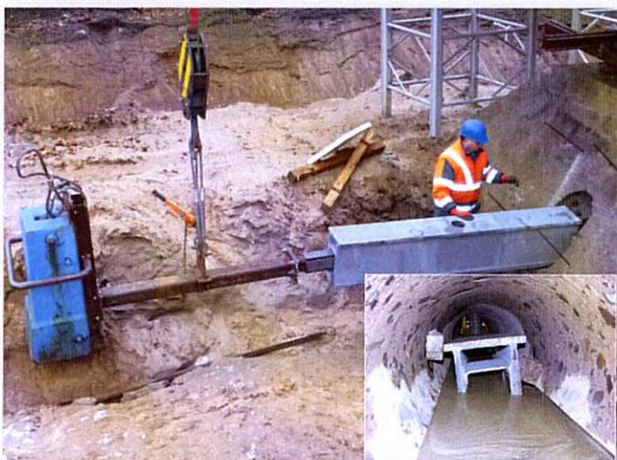
Der Verteilungsträger wird eingesetzt, mit dem neuen Hauptanker verbunden und danach vergossen.
