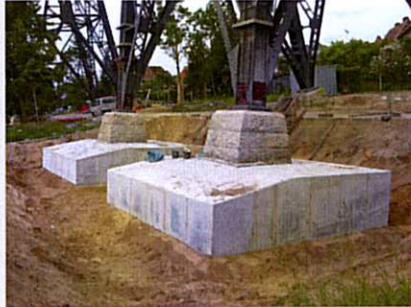
Die Verstärkung der Fundamente erfolgt im Pilgerschrittverfahren, da benachbarte Brückenpfeiler aus statischen Zwängen heraus nicht gleichzeitig verstärkt werden dürfen.
