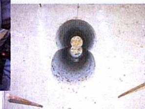
Für den Einbau des Verteilungsträgers als Anschluss für den neuen Hauptanker ist eine überschnittene Horizontalbohrung in Brückenlängsachse notwendig. Je nach statischen Erfordernissen sind das Bohrungen im Durchmesser 400 mm bzw. 440 mm.
