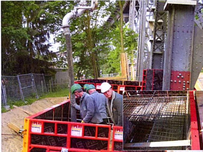
Es wird immer ein Doppelfundament inklusive des zugehörigen Koppelbalkens betoniert.
