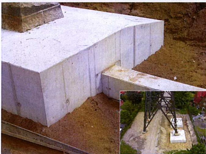
Das ausgehärtete Fundament wird von seiner kompletten Schalung befreit und später die Baugrube wieder verfüllt.
