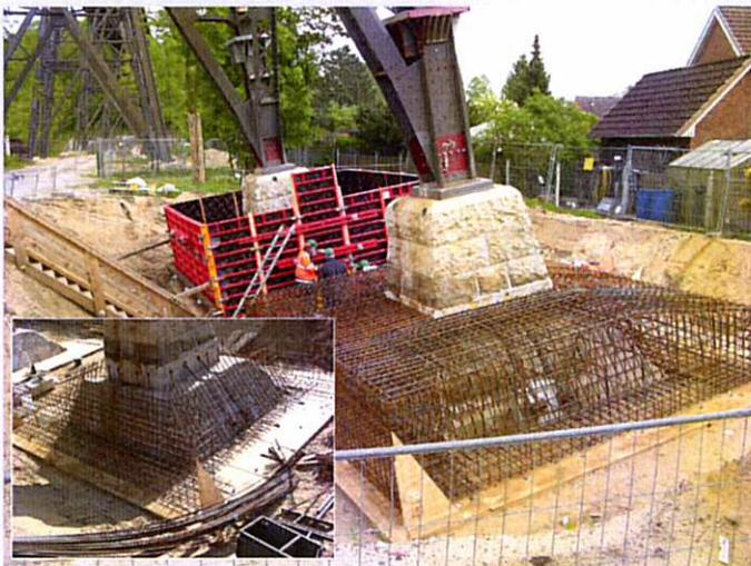
Nach Demontage der Baubehelfskonstruktion und Erstellen der unterseitigen Schalung wird der Bewehrungskorb der Betonergänzung hergestellt.
